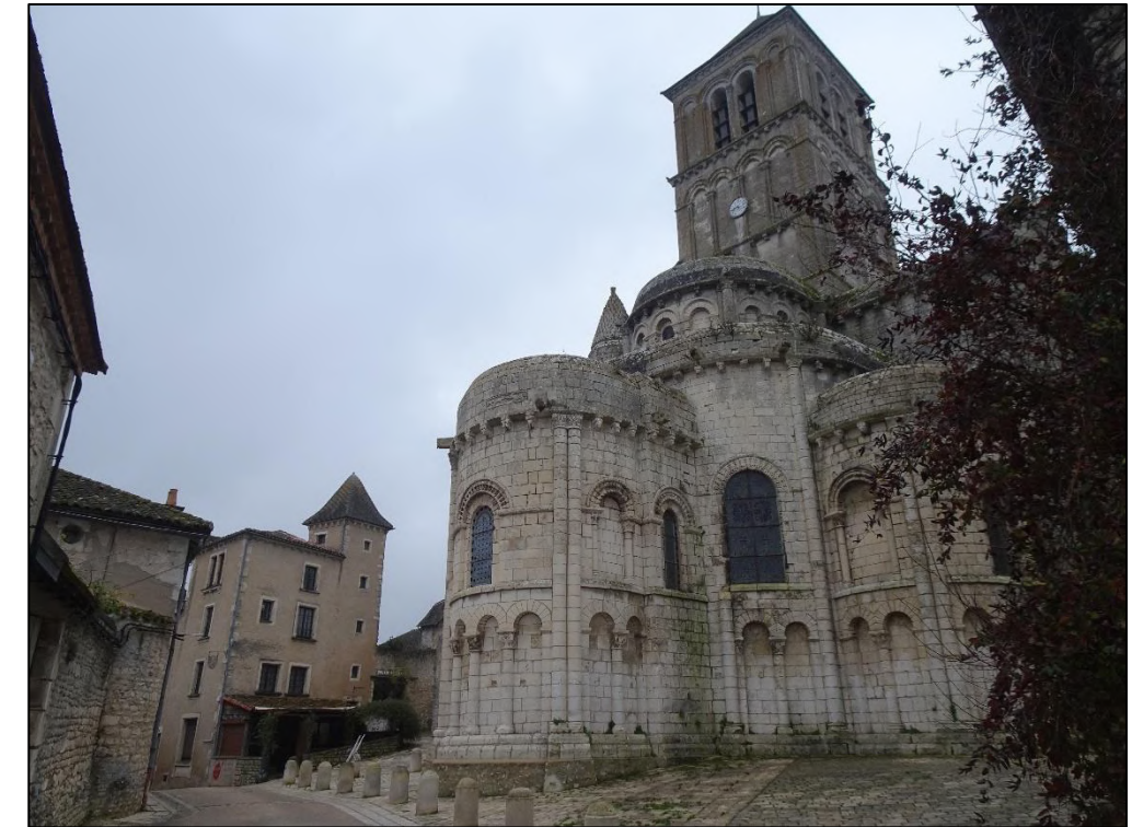
Figure 145 : Prise de vue 1 - photographie de l'Eglise collégiale de Saint-Pierre
