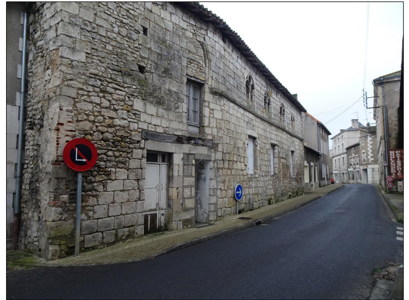
Figure 154 : Prise de vue 1 - photographie du monument historique, en direction du site d'étude
